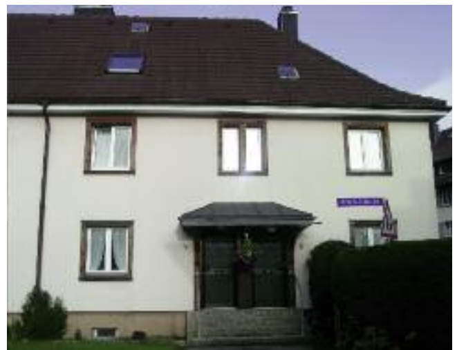
Beginn der Häusererneuerung Wilhelm-Sutter-Straße 2-4
