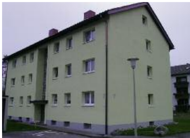
Erstes Haus des Bauvereins mit Zentralheizung 1961: Ahornweg 7
