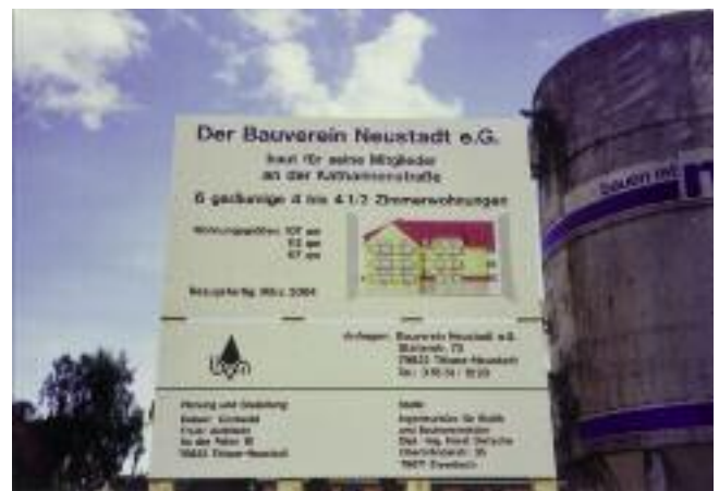
Baubeginn an der Katharinenstraße 12
