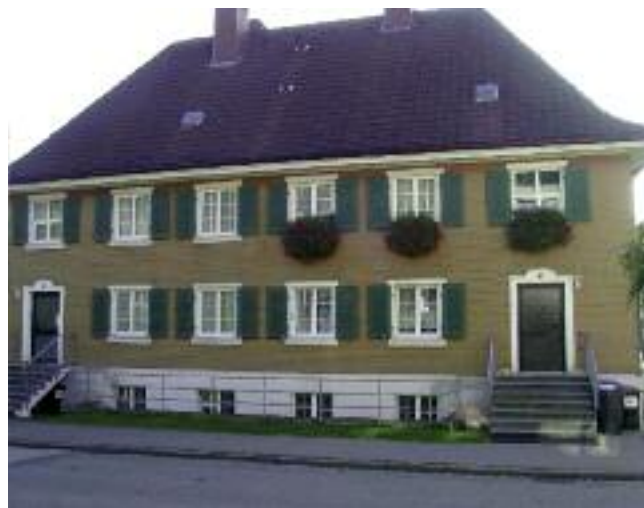
Haus des Bauvereins an der Stalterstraße
